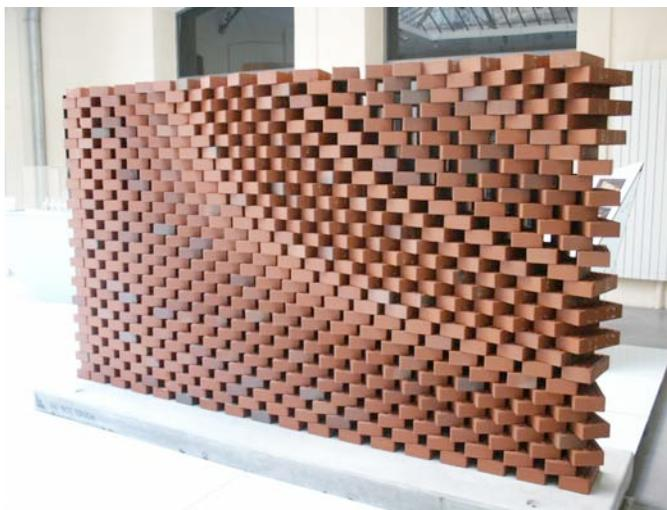
**Image 19 :** "Fabio Gramazio et Mathias Kohler : Mur de briques. Laboratoire de fabrication robotisée d'Fab de l'Ecole Polytechnique de Zurich."
